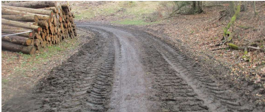
Abbildung 47: Beispiel einer Radwegeverbindung, die nach Forstarbeiten nur noch eingeschränkt nutzbar ist (eigenes Foto (VAR+, 2021))
